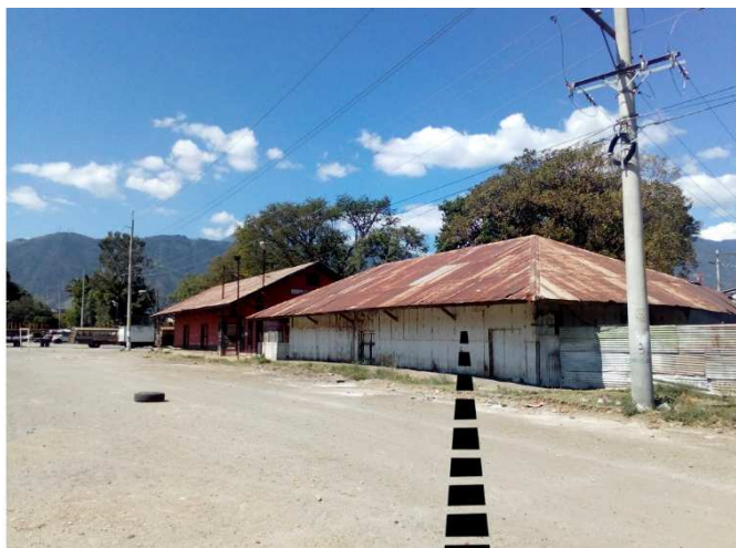
Figura 94. Vista trasera antigua bodega de la estación. (Fuente: elaboración propia).
