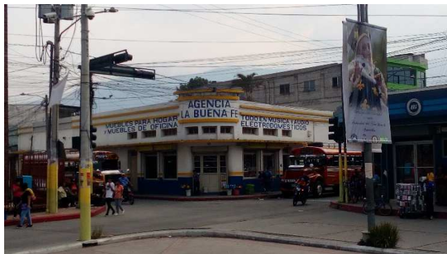
Figura 63. Vista Agencia La Buena Fe, evidencia de los problemas de imagen urbana. (Fuente: fotografía propia).
