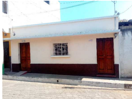
Figura 62. Vivienda de finales de la década de los 70, sistema constructivo de mampostería guarda características de las construcciones antiguas. (Fuente: fotografía propia).
