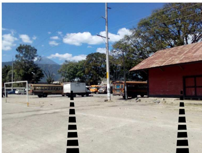
Figura 95. Vista trasera desde campos. (Fuente: elaboración propia).
