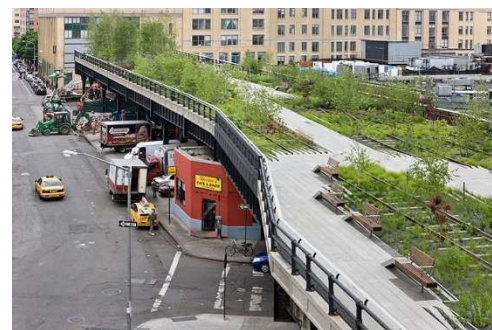
Figura 25. Vista actual de la intervención de la línea férrea. (Fuente: Plataforma Arquitectura)
