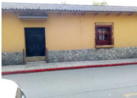
Figura 60. Fachada de casa de principios de los 80. (Fuente: fotografía propia).
