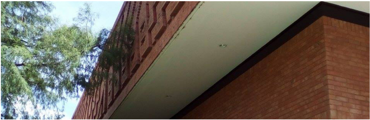
Figura 6.1.65 Fotografía Iluminación Exterior Imagen Propia
