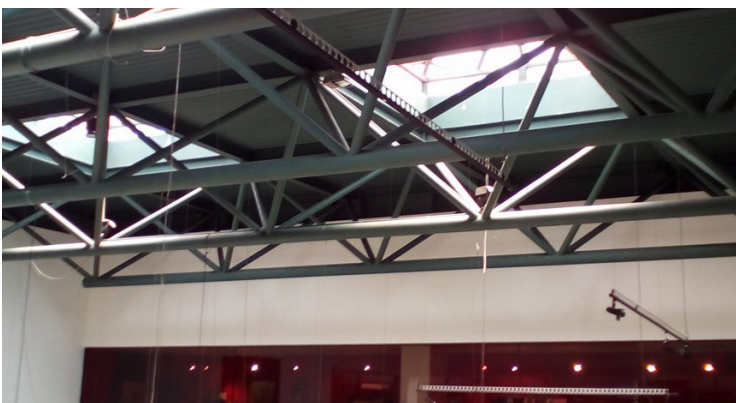
Figura 6.1.59 Fotografía Techo Imagen Propia
