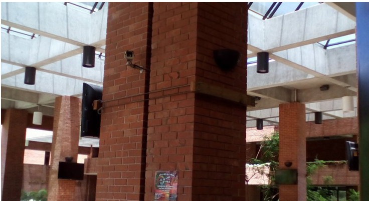
Figura 6.1.58 Fotografía Columnas Imagen Propia
