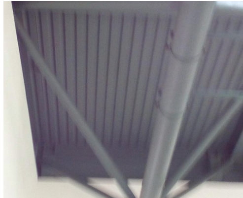
Figura 6.1.64 Fotografía Techo 2 Imagen Propia
