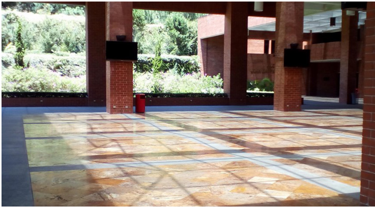
Figura 6.1.75 Fotografía Plaza Exterior Imagen Propia
