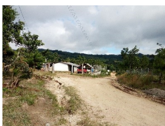
Figura 88. Vista general de la vivienda que cuenta con tienda en el caserío. Fuente: Elaboración propia.
