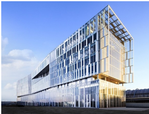
Figura 17. Oficinas centrales de la Caja de ahorro de Bordeaux, Francia. Fuente: AS Arquitectura Fuente: http://www.architecture-studio.fr/en/
