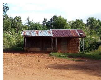
Figura 96. Primera tienda construida con adobe y su aplicación con block pómez. Fuente: Elaboración propia.
