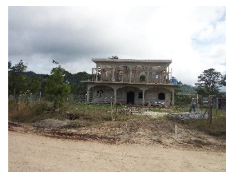
Figura 87. Vista general de una de las viviendas que se están construyendo actualmente en el caserío. Fuente: Elaboración propia.
