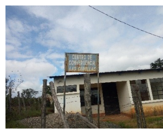
Figura 90. Centro de salud en Las Cebollas. Fuente: Elaboración propia.
