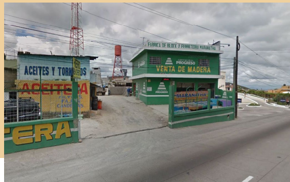
Figura 80 | Aceitera, fábrica de block y venta de madera. Uso de suelo comercial e industrial. Fuente: Google Street View, 2016.
