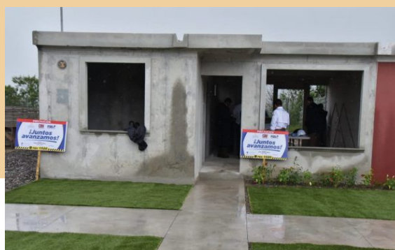
Figura 147 | Obra gris finalizada. Fuente: https://bit.ly/2Y2L8ql
