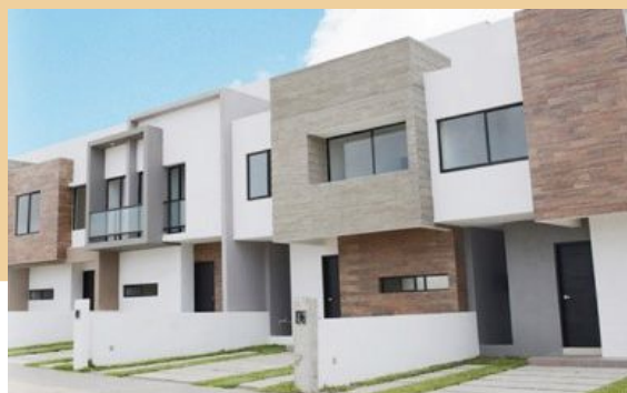
Figura 155 | Vista exterior de un modelo de vivienda. Fuente: https://bit.ly/2Y2L8qj
