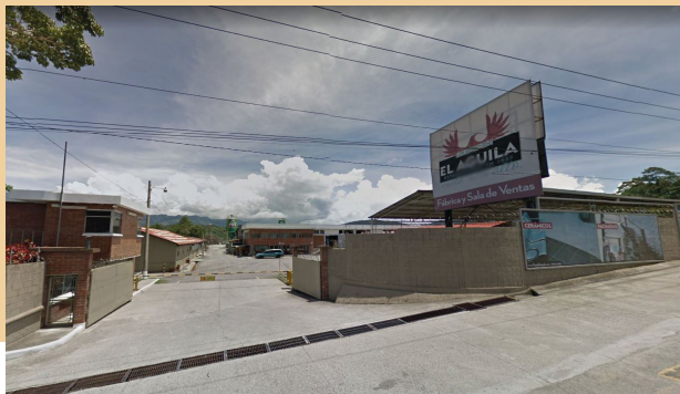
Figura 79 | Fábrica de pisos El Águila, uso de suelo industrial, condicionado II. Fuente: Google Street View, 2016.
