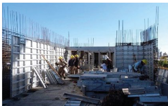
Figura 156 | Construcción de la vivienda con formaleta metálica. Fuente: https://bit.ly/2VFZJGB
