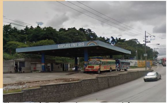
Figura 91 | Equipamiento comercial, gasolinera. Fuente: Google Street View, 2016.
