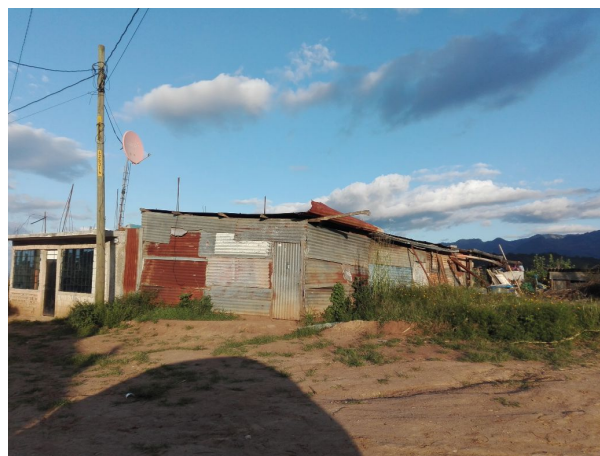
Figura 3 | Viviendas de construcción informal.
