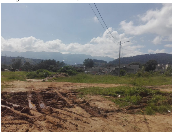
Figura 4 | Falta de pavimento y aceras.
