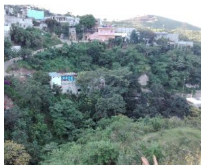
Figura 132 | Vista Oeste hacia viviendas y CA-1. Fuente: Aleiram de Paz, 2019.
