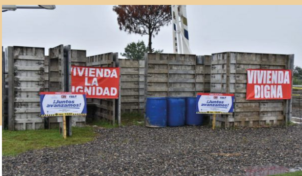
Figura 146 | Construcción de vivienda con formaleta metálica. Fuente: https://bit.ly/2Y2L8ql
