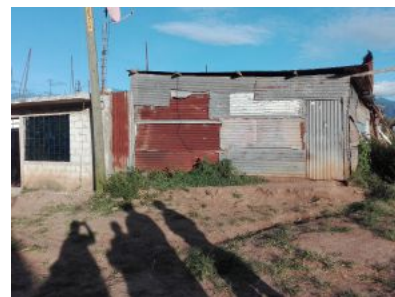
Figura 105 | Vivienda informal de cubiertas de lámina. Fuente: Aleiram de Paz, 2019.
