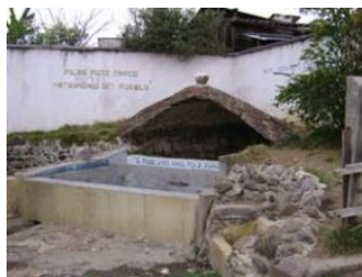
Pila y pozo Zarco
