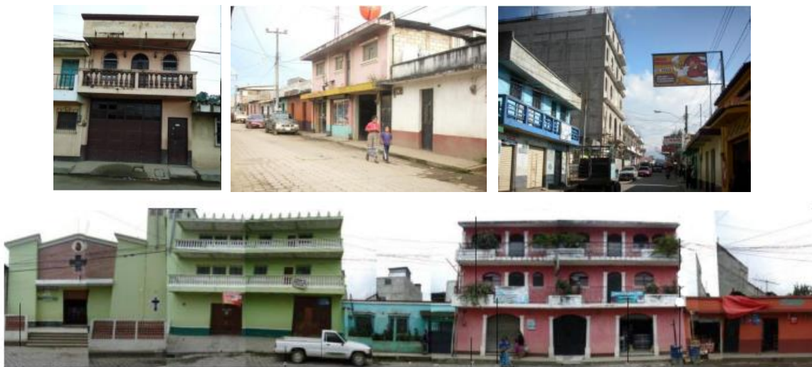
Figura 56: Viviendas con muros de mampostería Fuente: Ludwin Chalí, 2013
