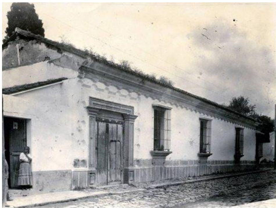
Fig. 12: Fotografía de Casa Popenoe en el año 1930. Fotografía tomada de: https://newmedia.ufm.edu/video/restauracion-de-la-casa-popenoe/
