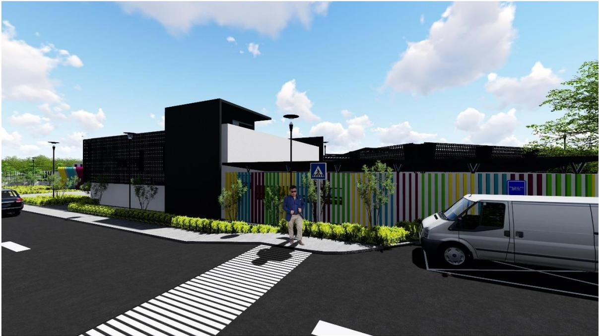
**FACHADA ÁREA DE GUARDERÍA:** Se visualiza la colocación de celosillas como solución a la incidencia solar, así como una bahía vehicular de carga y descarga.
