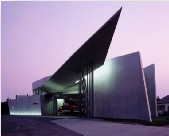
Figura 18. Estación de Bomberos Vitra / Zaha Hadid https://www.plataformaarquitectura.cl/cl/920917/clasicos-de-arquitectura-estacion-de-bomberos-vitra-zaha-hadid
