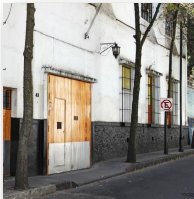
Figura 11. Clásicos de Arquitectura: Capilla Capuchinas / Luis Barragán https://www.plataformaarquitectura.cl/cl/02-207404/clasicos-de-arquitectura-capilla-de-las-capuchinas-luis-barragan
