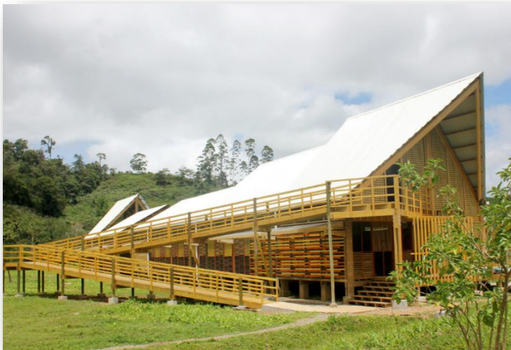
Figura 22. Centro de Capacitación Indígena Kăpäclăjui / Entre Nos Atelier
