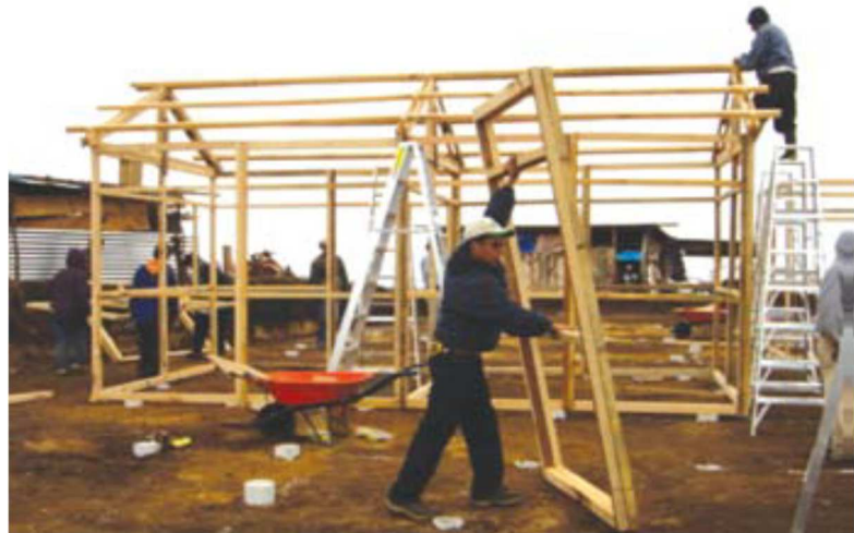
Imagen No. 29 – Construcción albergue de transición unifamiliar (ATU), STAN. https://www.url.edu.gt/publicacionesurl/FileCS.ashx?id=40785
