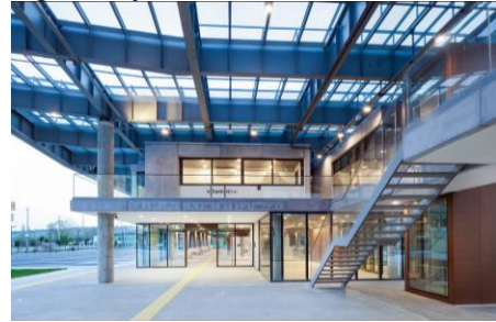
Ilustración 9 Vista de Cubierta
