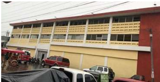
Fotografía 2 Vista de fachada Fuente propia
