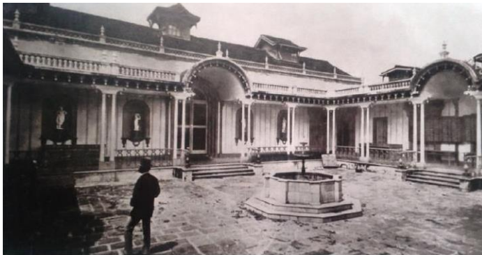
Figura 34. Vista interior del Edificio - Fuente: Urruela 2006
