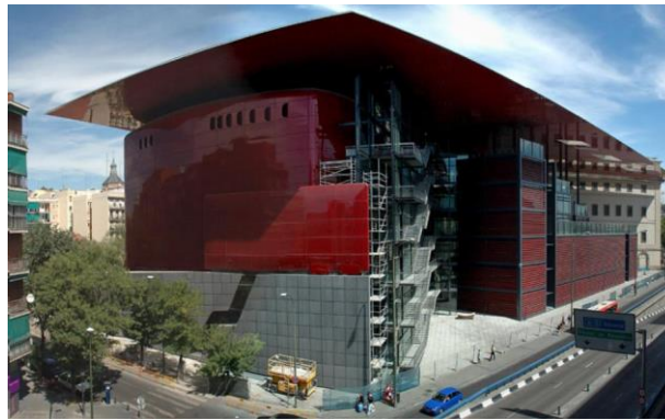
Figura 44. Ampliación Museo Reina Sofía - Fuente: https://constructalia.arcelormittal.com/es/casos_practicos/espana/ampliacion_de_l_museo_reina_rofia_madrid
