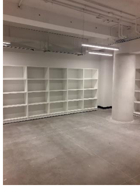
Bodega transparente para almacenamiento de piezas.
