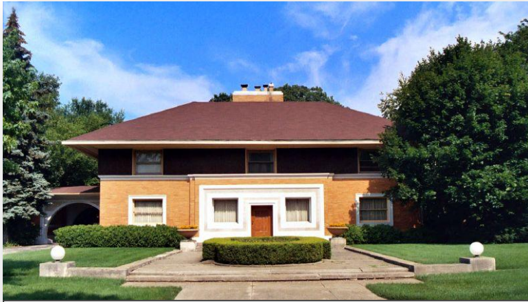
Figura 20 = Frank Lloyd Wright, casa Winslow, Illinois, 1893. Fuente https://es.wikiarquitectura.com/edificio/casa-winslow/#casa-winslow-4
