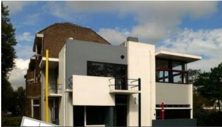
Figura 24 = Casa Schröder-Schröder, Utrecht, en 1927, por el Arq. Gerrit Rietveld, grupo de Stijl. Fuente: https://www.archdaily.mx/mx/02-75429/clasicos-de-arquitectura-casa-rietveld-schroder-gerrit-rietveld
