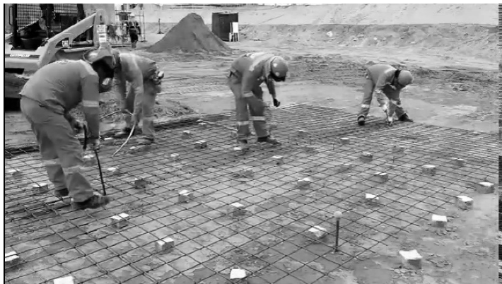
Imagen 2 - Preparación de área, malla electro soldada.
