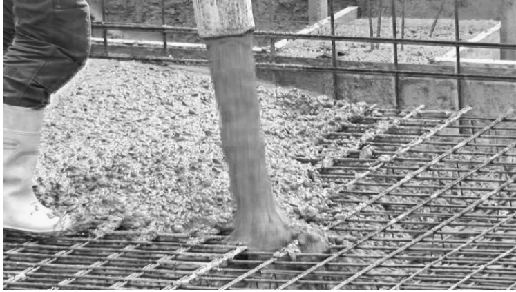
Imagen 3 – Colocación de concreto sobre malla electro soldada.
