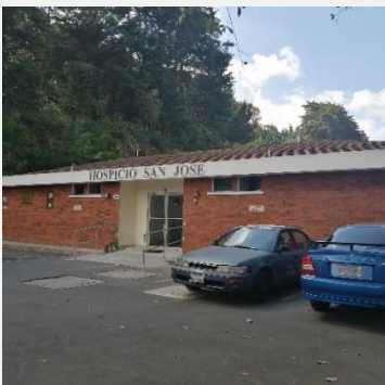
Imagen no. 29 Récord fotográfico, Fachada frontal. Fuente: elaboración propia
