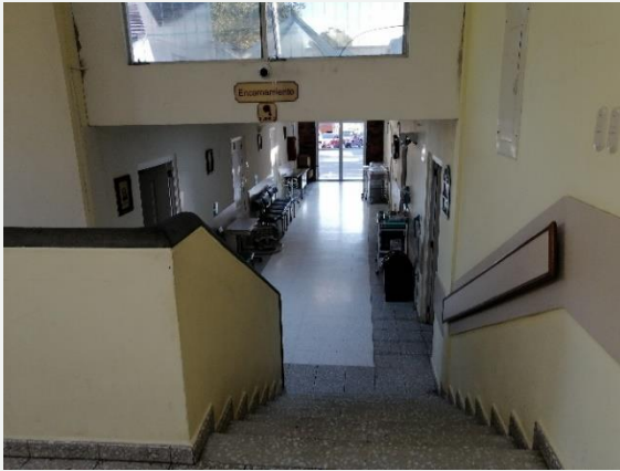
Imagen no. 17 Récord fotográfico módulo gradas. Fuente: elaboración propia
