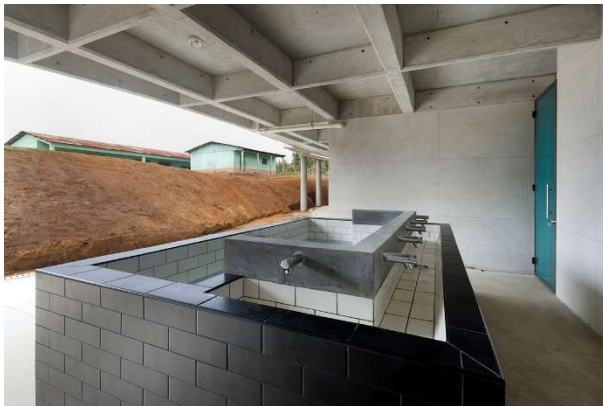
-Figura 38- Servicio Sanitario, Escuela San Felipe Chenla
