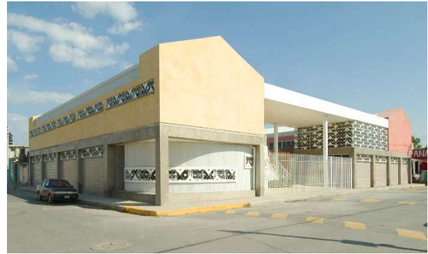
-Figura 41-Exterior del Centro Comunitario Chalco
