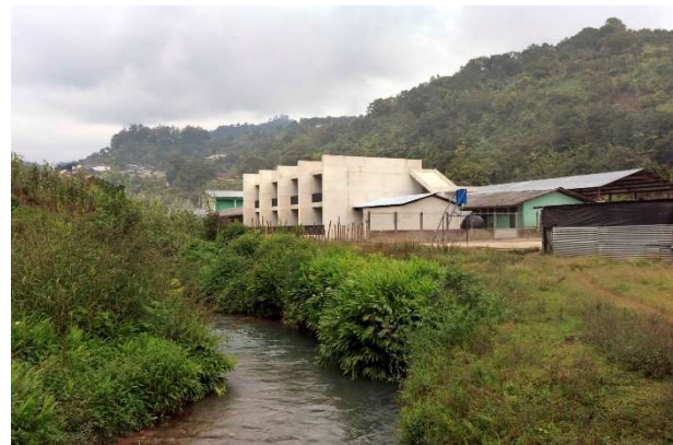
-Figura 34- Vista de la Escuela San Felipe Chenla desde el Río.
