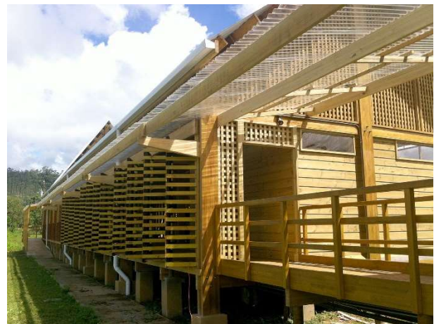
-Figura 60- Vista Exterior sobre Pasillo Principal, Centro de Capacitación Indígena Kăpäcläjui
