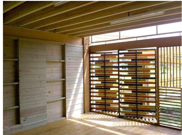
-Figura 56- Puertas Internas Centro de Capacitación Kăpäcläjui
