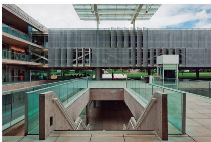
Figura No.14 Plaza principal y escalera que interconectan la planta baja con el área de ingreso principal al edificio. Fuente: www.plataformaarquitectura.cl
