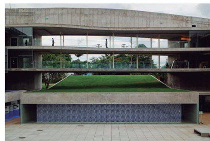
Figura No.15 Fachada Este, con pasillos que interconectan los extremos norte y sur del edificio por medio de pasillos que a su vez son áreas de estar. Fuente: www.plataformaarquitectura.cl
