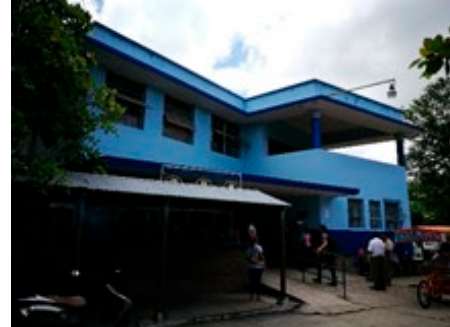
Figura No.5 Fachada Hospital Regional de Zacapa Fuente Propia
