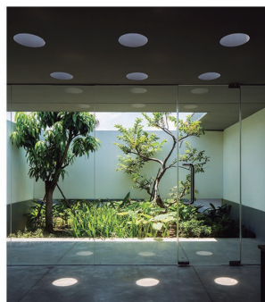
Figura No.21 Las perforaciones en el techo permiten que la luz atraviese el mismo y deja percibir durante todo el día el paso del tiempo por la posición del sol. Fuente: www.plataformaarquitectura.cl
