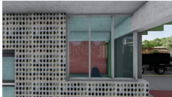
MURO DE RELLENO, ELABORADO A BASE DE CONCRETO, Y BOTELLAS DE VIDRIO RECICLADAS.
