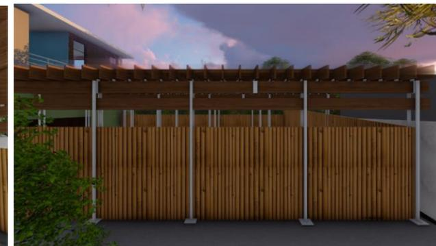
**3** UTILIZACIÓN DE PÉRGOLAS DE MADERA PARA LA CUBIERTA Y ESTRUCTURA METÁLICA PARA EL ÁREA DE COMPOSTAJE.
