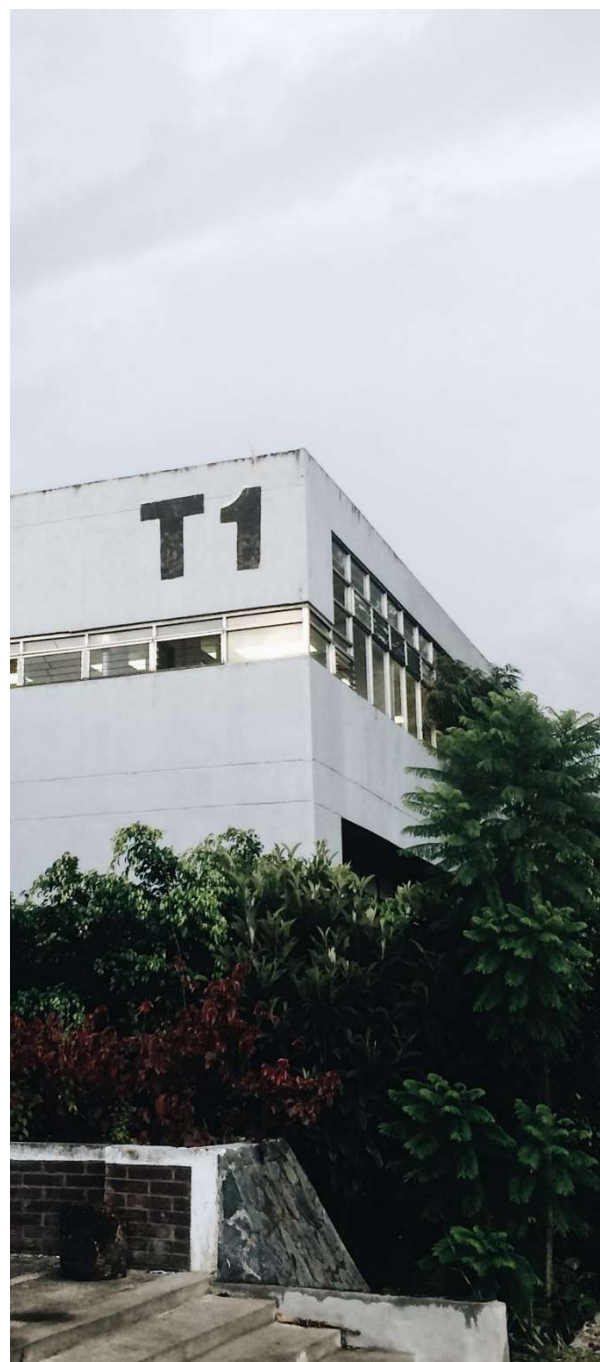
Figura 18: EDIFICIO T1-Fachada Fuente: José Alberto Coronado. 2019
