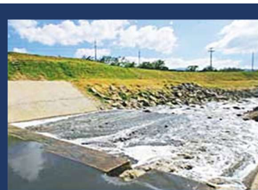
Figura 25. Canalización del río Villa Lobos
