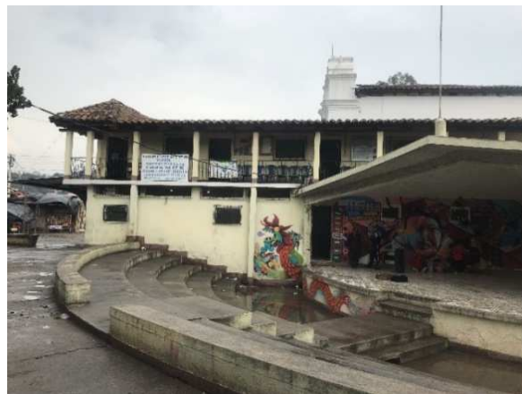
Figura No. 6 Áreas del teatro al aire libre en la que se observa poco espacio para actividades masivas. Fuente: Víctor Manuel Pérez. 2018.
