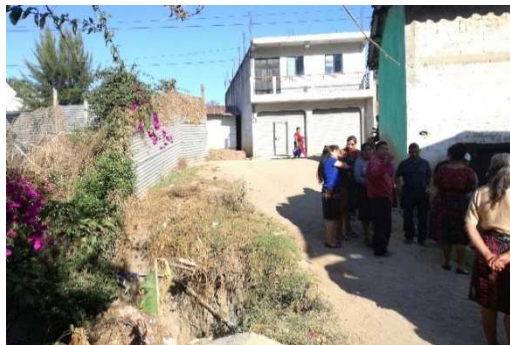
Figura No. 77. Puente ubicado en Chilimá, el cual fue destruido por el aumento del caudal del río en la tormenta Agatha , año 2010. Fuente: Víctor Manuel Pérez, 2018.
