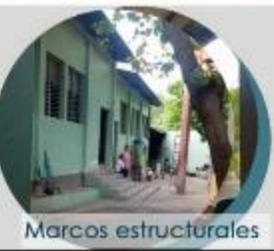
Construido por fases, con luces medianas con marcos de acero perfil "I", construcción levantado tradicional con columnas y soleras. Con elementos de carácter funcional en toda la construcción.
