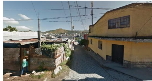
h. Vivienda sobre la 1ª. avenida.
