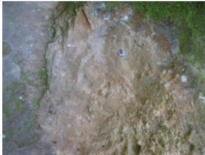
Foto 4: Tipo de suelo en el proyecto. Elaboración: Propia
