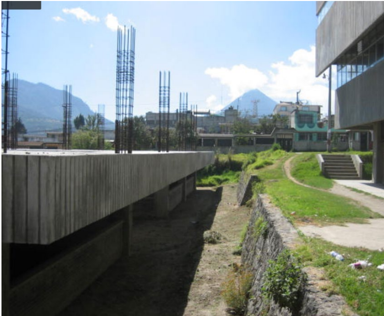
“Edificio en construcción, CUNOC” Imagen: Oscar Sánchez, abril 2019
