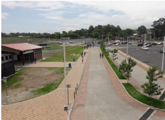
Figura 25/ Vista del acceso peatonal
