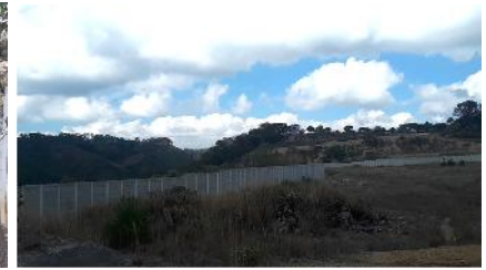
Figura 71/ barda colindancia Sur y Oeste
