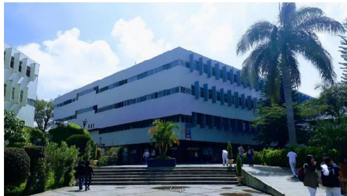
Figura 14 / Edificio y plaza CUM ZONA 11
