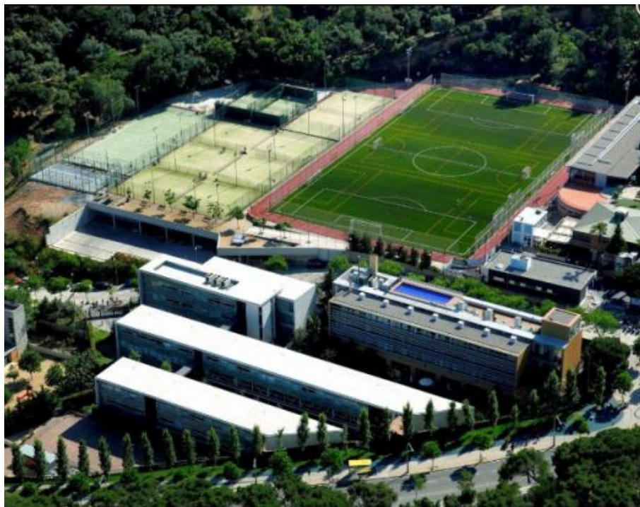
Figura 34/ Vista aérea posterior edificios RUCS
