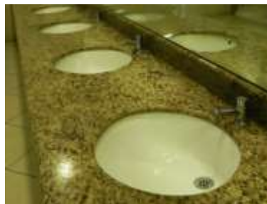
Foto No.21 Área de lavamanos, en servicios sanitarios. Elaboración propia.
