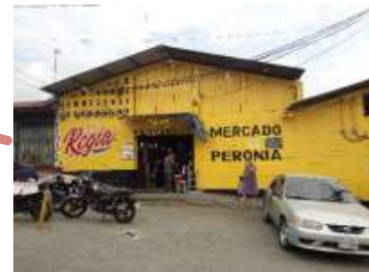
Foto No.10 Elaboración propia Fachada principal del mercado actual.
