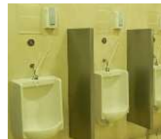
Foto No. 22 Área de urinales, servicios sanitarios, techo. Elaboración propia.
