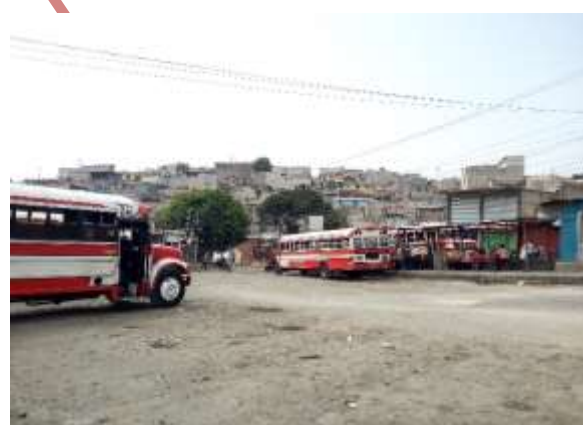
Foto No.8 Elaboración propia. Parada de buses extra urbanos presenta malas condiciones en su infraestructura.
