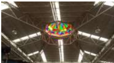
Foto No.19 Estructura Metálica, techo. Elaboración propia.
