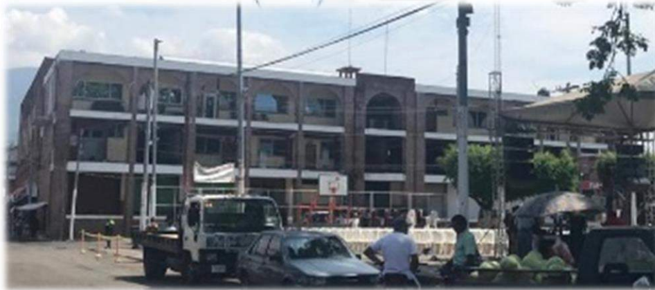
Figura 52. Fachada de la Municipalidad de Taxisco. Fuente: Propia
