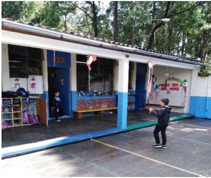
Figura 60. Fachada de módulo de aulas frente a cancha.
