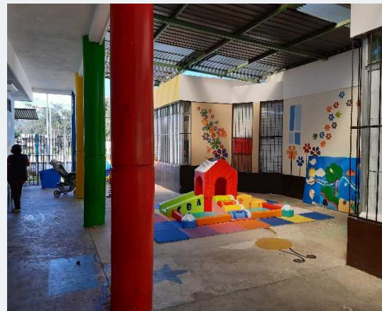
Figura 76. Ventanas de aulas. Fuente: propia.
