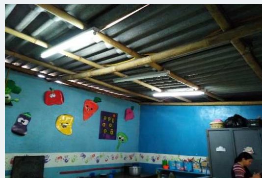
Figura 62. Techo de lámina con estructura de bambú. Fuente: propia.
