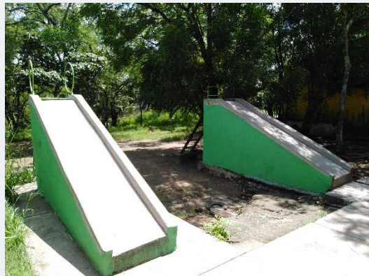
Figura 24. Espacios recreativos en mal estado Fuente: propia (abril 2019).
