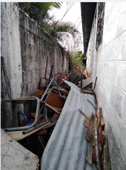
Figura 9. Servicios sanitarios Escuela Primaria de San Miguel Conacaste Fuente: propia, (marzo 2019).
