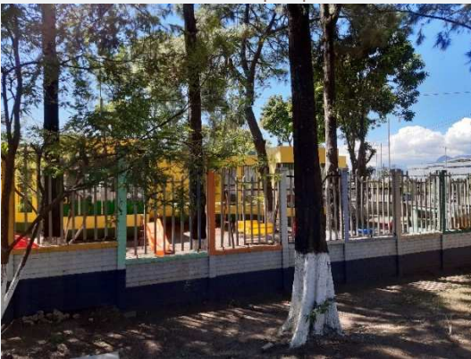
Figura 83. Muro perimetral Jardín Infantil. Fuente: propia.
