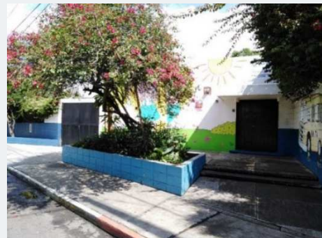
Figura 59. Fachada Escuela R. de Haití. Fuente: propia.
