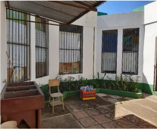
Figura 74. Ventanas de aulas. Fuente: propia.
