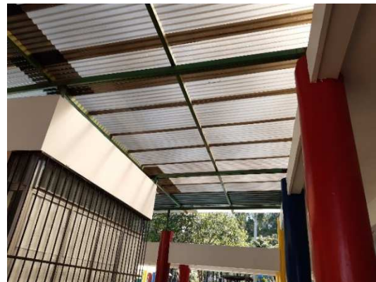
Figura 84. Cubierta de lámina y estructura metálica en patio de juegos. Fuente: propia.
