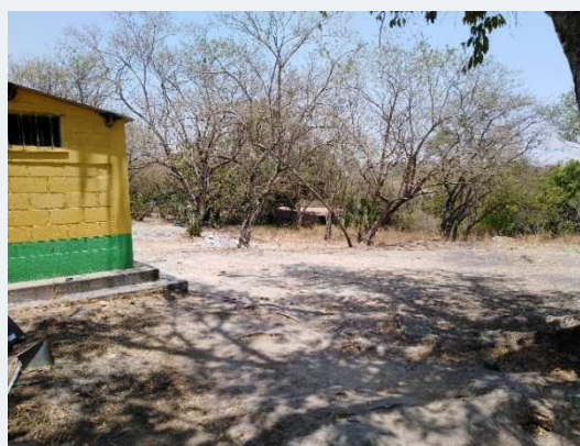
Figura 12. Presencia de raíces de árboles en los alrededores de la escuela. Fuente: propia (abril 2019).
