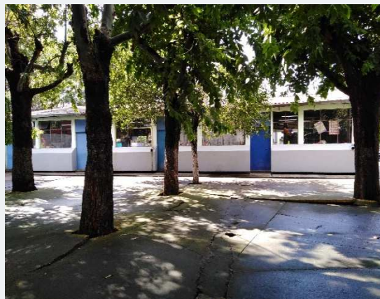
Figura 55. Ventanas y puertas traseras en aulas. Fuente: propia.
