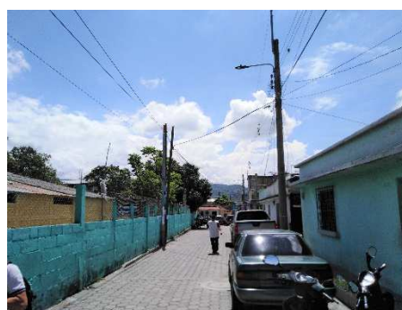
Figura 151. Postes de energía eléctrica e iluminación en calle de acceso. Fuente: propia (octubre 2019).
