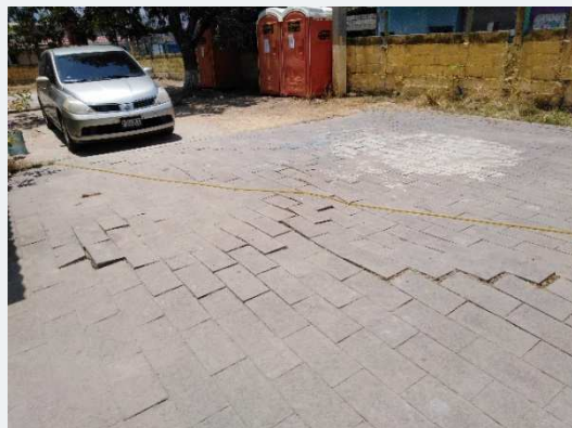
Figura 10. Adoquín levantado por raíces de los árboles. Fuente: propia (abril 2019).
