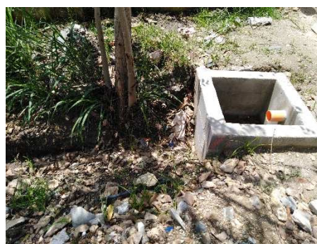
Figura 150. Cajas de drenajes. Fuente: propia (octubre 2019).
