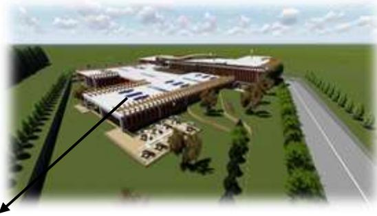
Paneles solares a utilizar en techo es SunPower X21 335, altura: 155,9 cm, anchura: 104,6 cm, espesor: 4,6 cm tamaño de celda PV: 15,6 x 15,6 cm número de células: 96. La energía generada por metro cuadrado: 205.43 vatios total a utilizar en el anteproyecto= 150 unidades x 205.43 vatios=37,564.7 vatios
