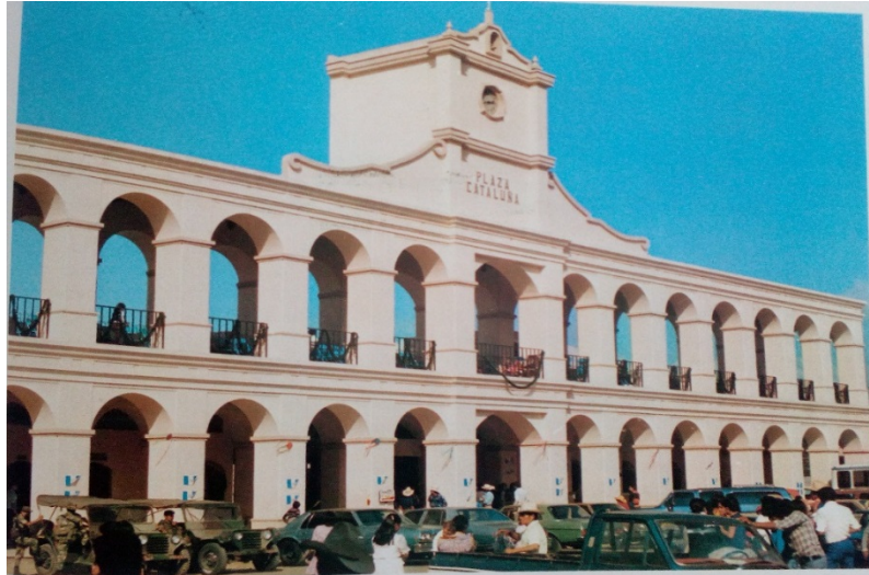
Figura 47: foto finalizada la construcción / extraído del libro Cataluña en Guatemala.
