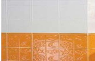
Utilizar azulejo a una altura no mayor de 1.80 en la parte interior donde se realiza el destace para una fácil limpieza.
