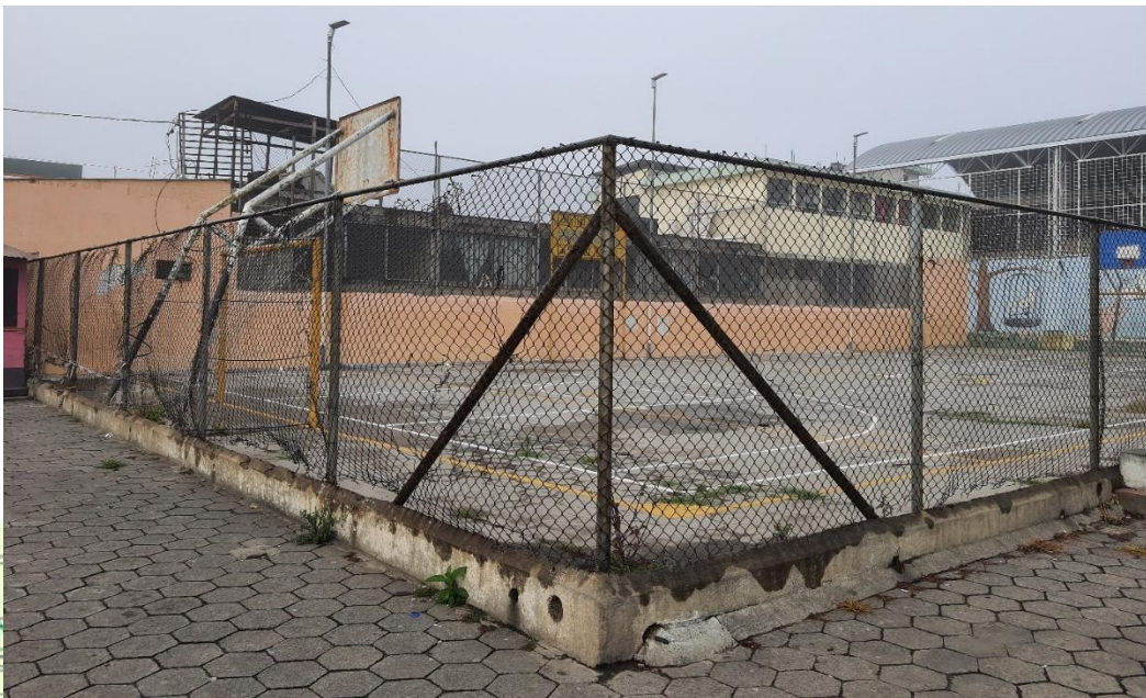
Imagen 39. Cancha polideportiva municipal
