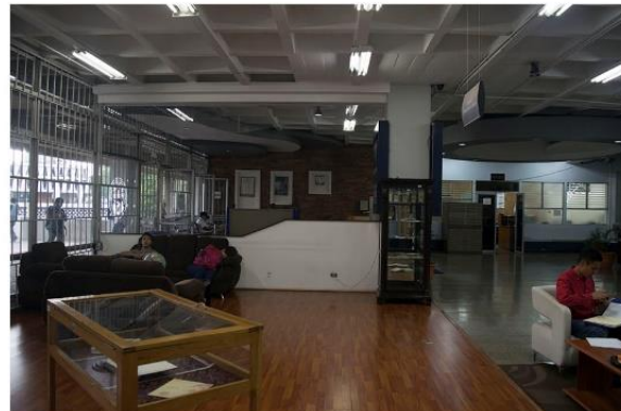
4. CONCRETO SUPERPOSICIÓN DE PINTURA COLUMNA / CUBIERTA
