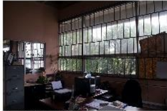
1. TABLAYESO / VIDRIO ALTERACIÓN DE ESPACIO INTEGRACIÓN DE AMBIENTES EN PASILLO
