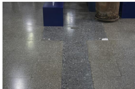
Figura 43. Piso de granito dentro de las instalaciones del edificio. Fotografía de Sergio Santana. 2019
