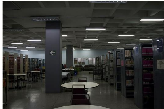
1. CONCRETO SUPERPOSICIÓN DE PINTURA MUROS Y COLUMNAS
