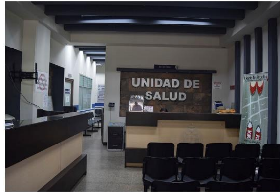
1. TABLAYESO SUSTITUCIÓN DE MATERIALES MUROS / CUBIERTA / COLUMNA
