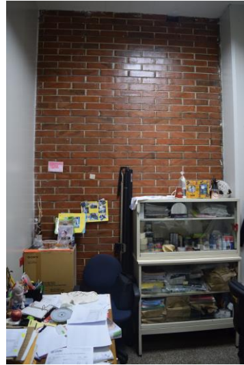
Figura 41. Cerramiento de muros de ladrillo. Fotografía de Sergio Santana. 2019
