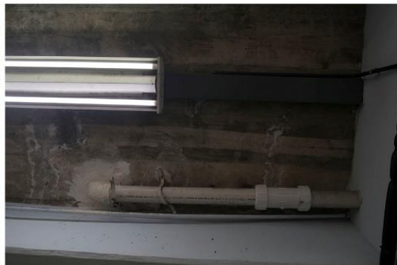
6. CONCRETO SUSTITUCIÓN DE MATERIAL CUBIERTA
