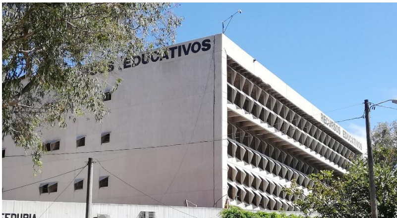
Figura 38. Uso de parteluces para protección solar y vista de fachada ciega con 18 aberturas para ventanas. Fachada afectada por el sol sureste. Fotografía de Sergio Santana. 2020
