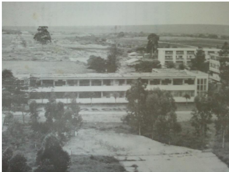
Figura 24. Edificio Antigua Facultad de Agronomía. Fotografía en tesis de grado Registro y Catalogación del antiguo edificio de la Facultad de Agronomía. 2016. Consultado 2019.
