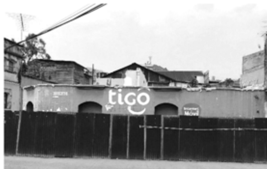
IMAGEN 32: Vivienda de la familia Guay en demolición, elaboración propia
