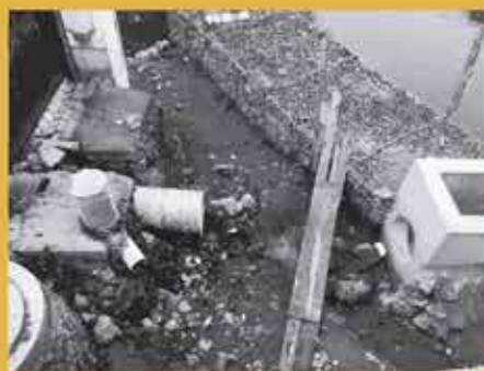
CONTAMINACIÓN AMBIENTAL EN RÍO COLIDANTE AL TERRENO
