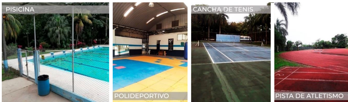
Figura 66– Análisis de la función de los ambientes en edificaciones dentro del Complejo Deportivo Santo Tomás de Castilla. ■ Fuente: Elaboración Propia.
