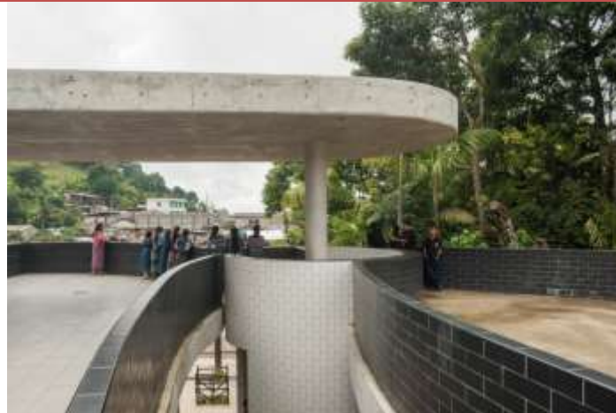
Figura 28, vista de la escuela https://www.plataformaarquitectura.cl
