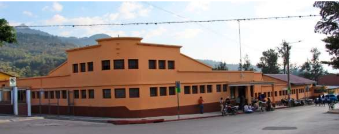
Figura 20, Vista de la Fachada Principal desde la Calle Real http://www.facebook.com/MuniPalenciaGT/
