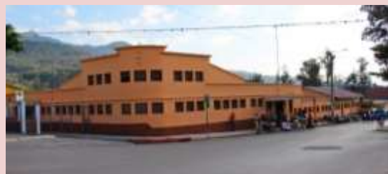
Figura 25, Vista de la Fachada Principal desde la Calle Real http://www.facebook.com/MuniPalenciaGT/
