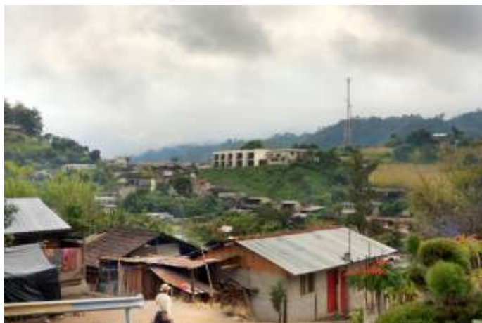
Figura 27, vista de la escuela en su contexto https://www.plataformaarquitectura.cl
