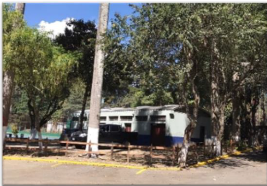
Figura 30, 31 y 32: Instalaciones de Club Deportivo Los Arcos, Fotografía de Claudia Ixcaquic, 2017
