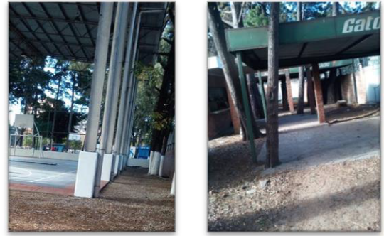
Figura 33 y 34: Instalaciones de Club Deportivo Los Arcos, Fotografía de Claudia Ixcaquic, 2017
