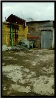
Figura 60: F-3: Debido a que el terreno ya cuenta con dos canchas de futbol, en este también se ubican 4 áreas de apoyo como bodegas, área de cobros, graderío y el área de servicios sanitarios que es el que se puede observar en la imagen, esta se encuentra construida con lámina y en muy mal estado, hay láminas sueltas y no es un área bastante sucia. Se puede observar también el muro perimetral el cual tiene humedad y moho.
