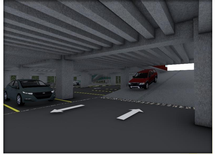
Figura 82: Sótano de parqueo: se puede observar el ingreso al mismo, como también el sistema estructural utilizado, el cual consta de marcos rígidos de concreto reforzado y una cubierta de molde LK para el mejor soporte del peso proveniente de las diferentes actividades realizadas en los niveles superiores.
