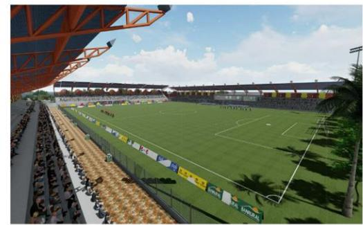
Se realiza un análisis de soleamiento en uno de los meses mas críticos en el municipio, época de verano, debido a la orientación del estadio. para mitigar la luz directa del sol y para un confort climático se utilizan cubiertas con estructura metálica para proyectar sombras en los graderíos.
