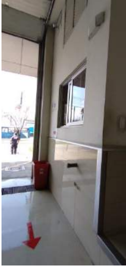
Imagen 46 Cabina exterior Fuente: fotografía propia, 2020.
