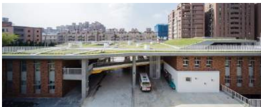
Imagen 59 Vista aérea posterior Fuente: Estación de Bomberos Da-Yo / K-Architect" [Da-Yo Fire Station / K-Architect] Nov. 2020. Plataforma Arquitectura.
