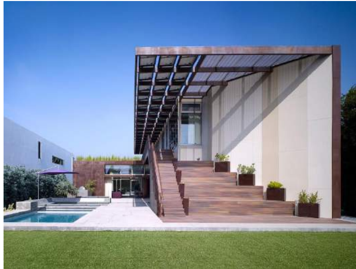
Imagen 13 Casa Ying Yang Fuente: https://brooksscarpa.com/yin-yang-house
