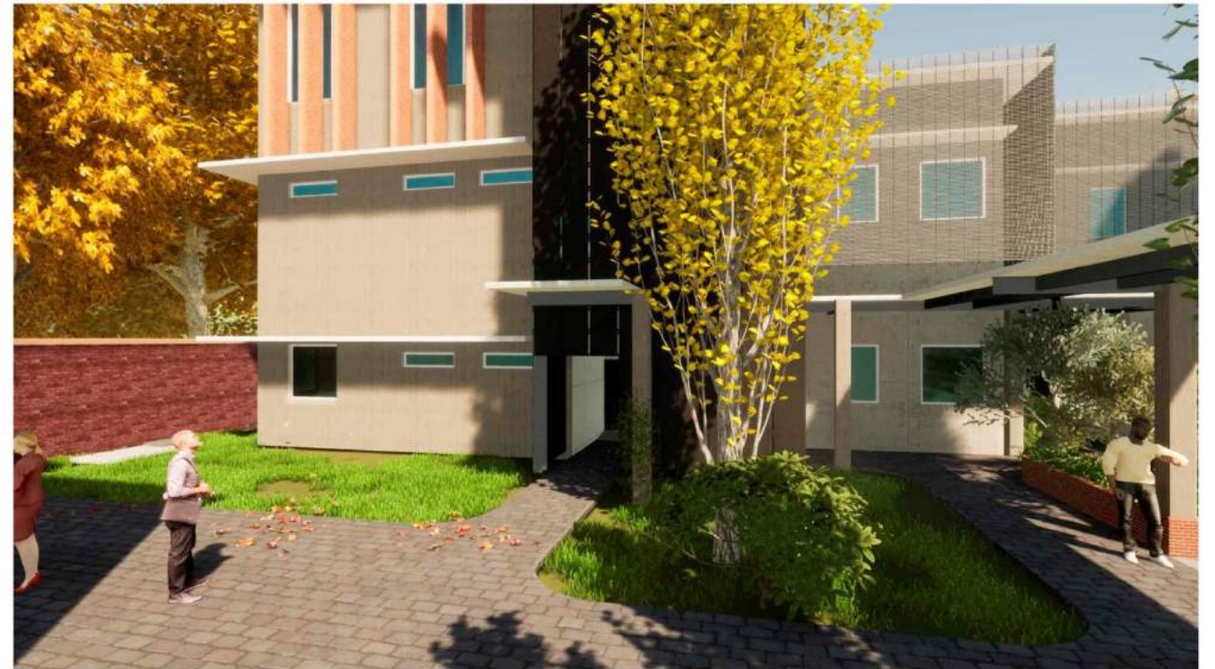
ÁREA DE ENTRENAMIENTO, Y DUCTO GRADAS EXTERIOR
