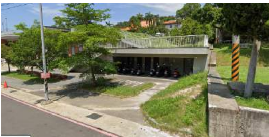
Imagen 54 parqueo motocicletas Fuente: Estación de Bomberos Da-Yo / K-Architect" [Da-Yo Fire Station / K-Architect] Nov. 2020. Plataforma Arquitectura.
