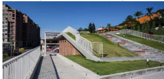
Imagen 63 Azotea a nivel de calle Fuente: Estación de Bomberos Da-Yo / K-Architect" [Da-Yo Fire Station / K-Architect] Nov. 2020. Plataforma Arquitectura.
