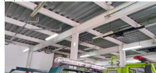
Imagen 31 Techo parqueo emergencias. Fuente: fotografía propia, 2020.
