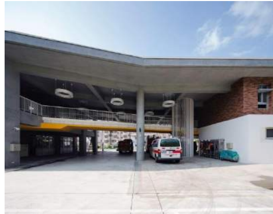
Imagen 62 Parque emergencias Fuente: Estación de Bomberos Da-Yo / K-Architect" [Da-Yo Fire Station / K-Architect] Nov. 2020. Plataforma Arquitectura.
