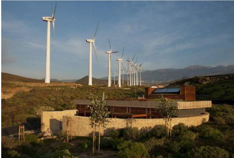
Imagen 10 Vivienda Bioclimática en Tenerife Fuente: http://www.ruizlarrea.com/proyecto/vivienda-bioclim-tica-en-tenerife
