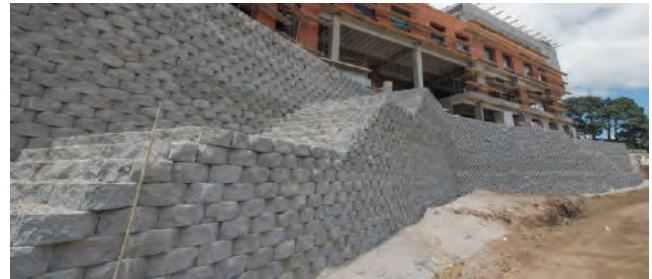
Figura 55. Muros, UNIS. Fuente: www.facebook.com/unisgt/photos/a.10152977019390054
