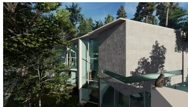
Panorámica de conjunto.
