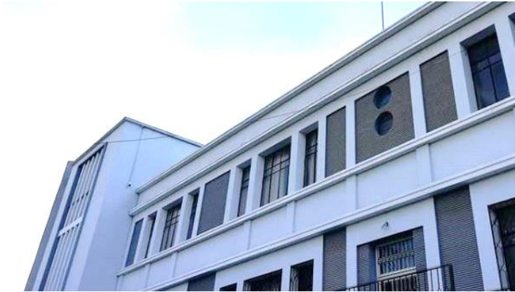
Figura 64 Vista general del edificio desde el exterior Fuente: Fotografías de Erik Morales, (Conservatorio Nacional de Música, Guatemala, 2019)
