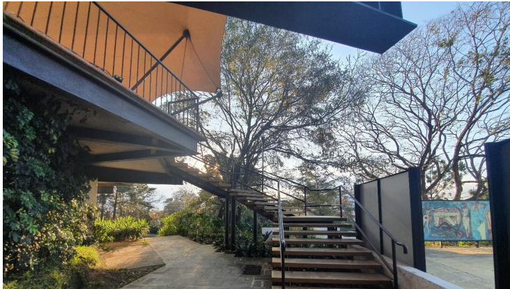
Figura 22 Vista general del edificio desde el exterior Fuente: Fotografía de Erik Morales, (Antigua Guatemala, Guatemala, 2020)
