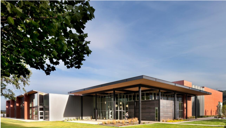
Figura 44 Vista general del edificio desde el exterior
