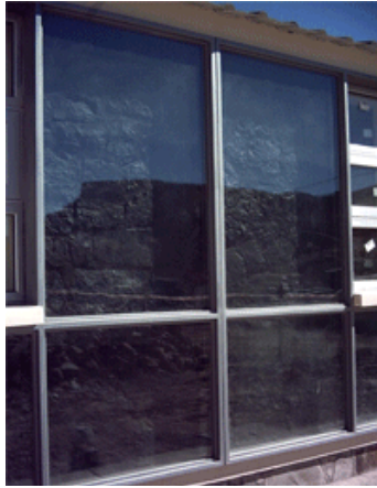
Imagen 23. Ventanas Fuente: Fotografía de Laboratorios de edificios bioclimáticos.
