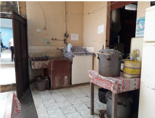
Imagen 8: Área de lavado de instrumentos. El espacio designado para lavar los instrumentos médicos se encuentra en malas condiciones. Fotografía: Aquiles Ortega López, 2019
