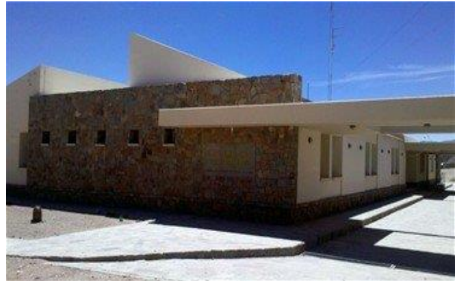
Imagen 21. Perspectiva Hospital de Susques. Fuente: Fotografía de Laboratorios de edificios bioclimáticos.
