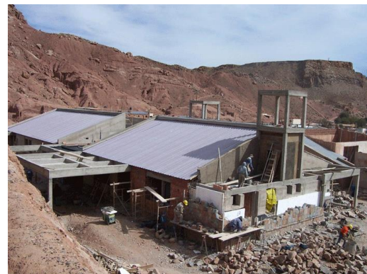
Imagen 26. Levantamiento de muros de piedra. Fuente: Fotografía de Laboratorios de edificios bioclimáticos.
