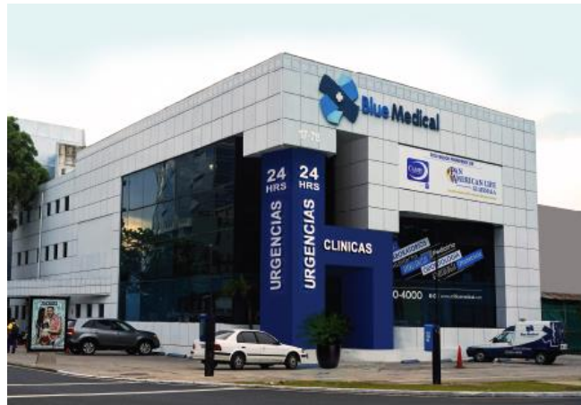
Imagen 12. Perspectiva Edificio Blue Medical Fuente: Fotografía de mibluemedical.com
