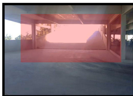
Ilustración 21 - Rampa vehicular, C. C. Peri Roosevelt, Calzada San Juan zona 7 - Fuente propia
