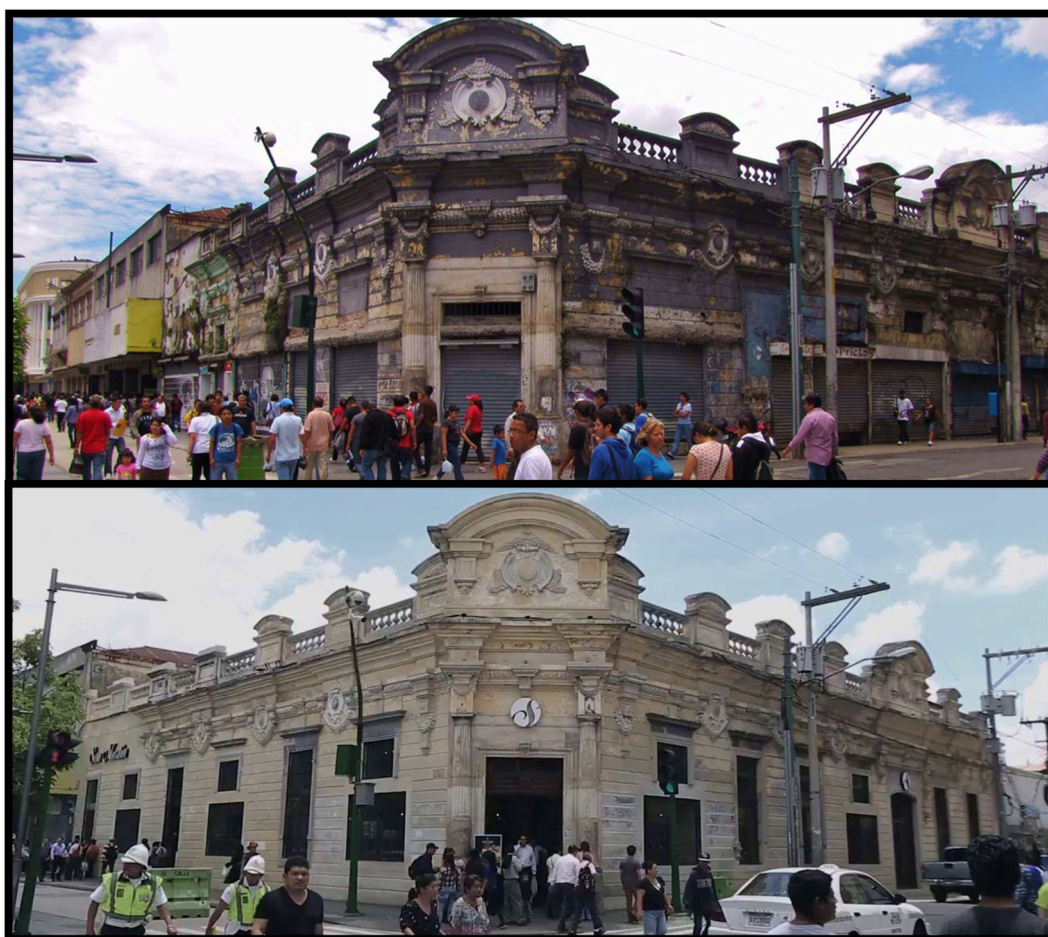
Ilustración 96 – Remodelación de Casa Pavón para dar paso a panadería y restaurante San Martín, 6 avenida 10-00 zona 1, Centro Histórico- Fuente www.prensalibre.com/c-studio/panaderia-revitaliza-casa-pavon-en-la-sexta-avenida/
