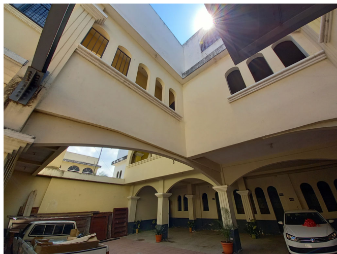
Fotografía 4a Complejo de casa parroquial ubicado del lado sur del templo.
