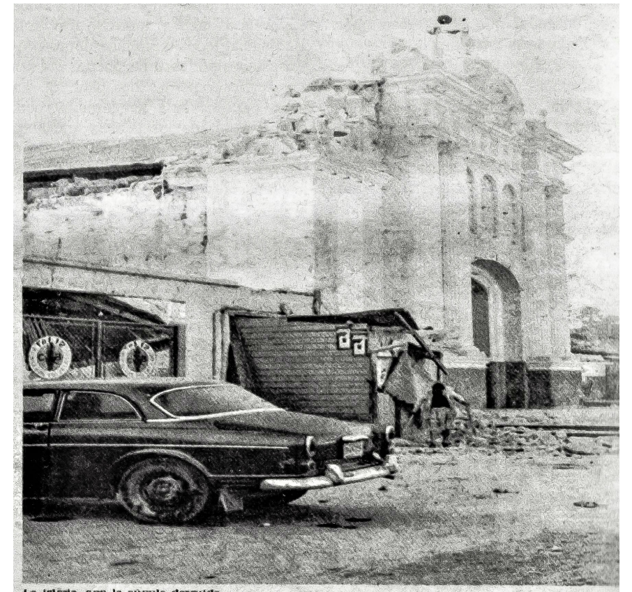
Figura 5 - Se observan los daños que causó el terremoto de 1976 en la Parroquia de la Inmaculada Concepción, los cuales, consistieron en el colapso del campanario norte y de una extensa porción del muro lateral norte del templo, cuyos escombros cayeron sobre la estación de bomberos voluntarios. Fotografía del periódico El Tiempo fechada el 6 de febrero de 1976, obtenida del libro Villa Nueva 1763-2013 250 años de Historia y Tradición , (2013), 108.
