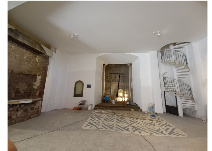
Fotografía 12 - Nótese la puerta principal, las escaleras tipo caracol y la parte baja de la losa que conforma el coro alto.
