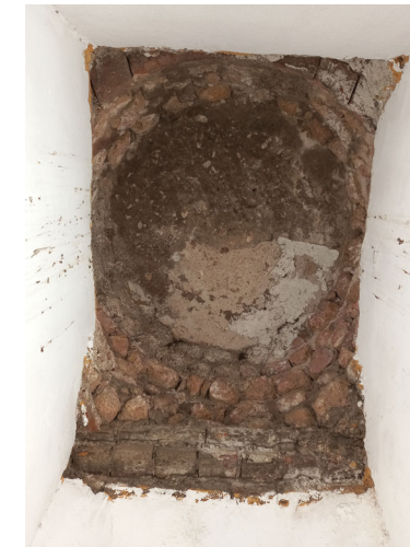
Fotografía 31 Izquierda: nótese el extremo final del tunel que comunica a la torre campanario sur con el lado norte. Centro: detalle de la cúpula de la torre sur conformada de ladrillo y argamasa (cúpula original). Derecha: detalle de la campana de la torre sur, fabricada en 1930 según registro histórico grabado.
