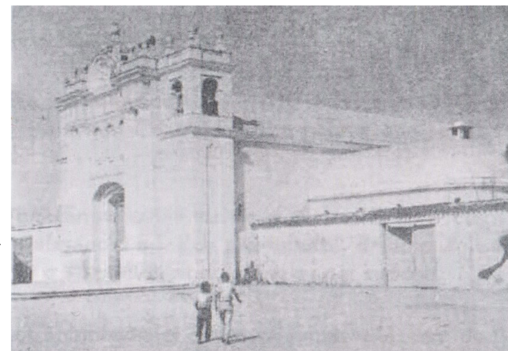
Figura 3 - Fotografía ca. 1958 en donde se observa el cambio de la cubierta a lámina de zinc, la demolición de la verja perimetral del atrio del templo y la cruz atrial, nótese la ausencia de remates o perillas en el muro lateral. Imagen obtenida del libro Villa Nueva 1763-2013 250 años de Historia y Tradición , (2013), 181.
