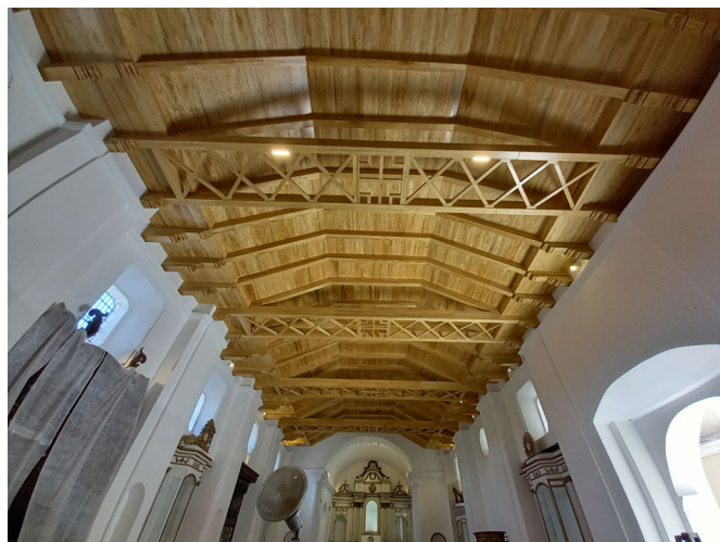
Fotografía 21a Detalle del cielo falso de madera de la nave.
