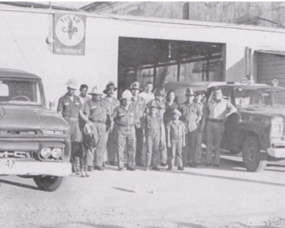
Figura 4.66 Estación de bomberos
