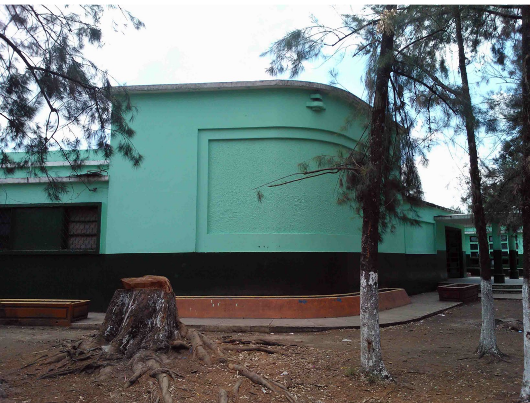
Figura 3.40 Escuela primaria La Escuela Tipo Federación No. 2 “17 de abril de 1763” es un inmueble de importancia patrimonial que sigue cumpliendo la función de albergar la educación primaria pública del municipio de Villa Nueva.
