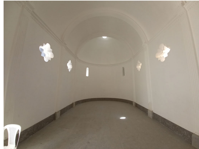
Fotografía 10 - Interior de capilla de Jesús de Trujillo, nótese la bóveda de cañón corrido, la semi cúpula, linternilla y ventanas.
