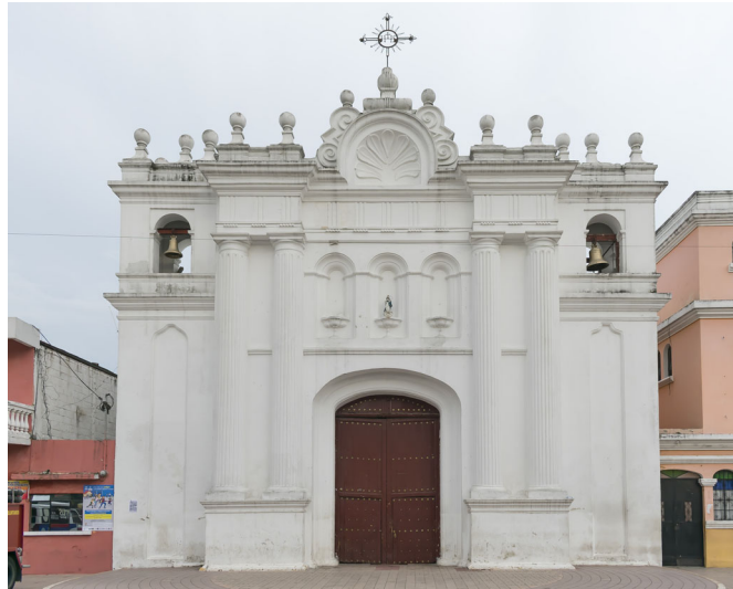
Fotografía 1 - Fachada principal (oeste u occidente)
