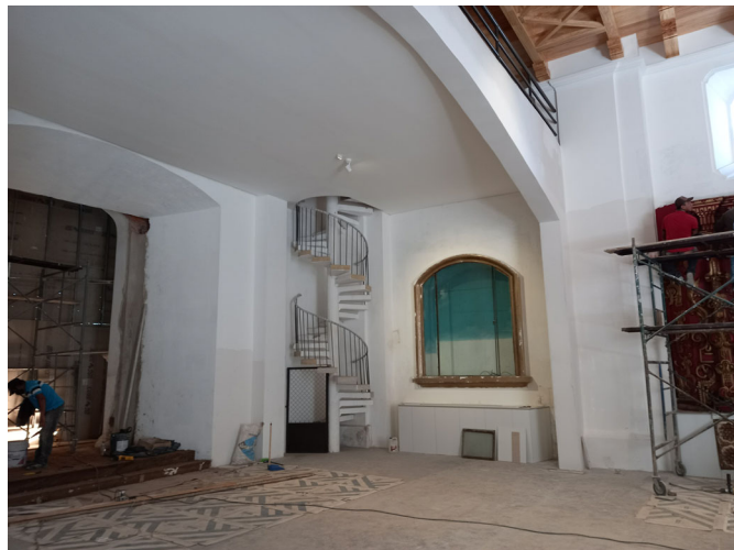
Fotografía 13 - Nótese la escalera tipo caracol hecha de concreto, la baranda helicoidal de acero y la estructura de soporte del coro alto.
