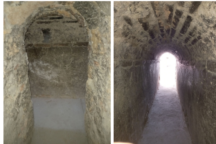
Fotografía 30 - En la imagen de la izquierda se aprecia el pasadizo en forma de tunel que atraviesa la fachada en sentido norte-sur para conducir a las dos torres campanario; en la imagen de la derecha se aprecia el tunel hacia el campanario sur.
