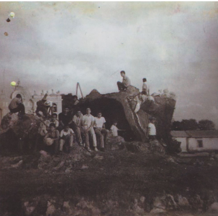
Figura 4.64 Derribo de ceiba, iglesia al fondo Fotografía de 1966, captura en ocasión del derribo o tala de la ceiba del parque central. A la izquierda, se observa la parte alta de la fachada de la iglesia. Abajo a la derecha, se aprecia la casa parroquial, nótese que la casa parroquial ya no tiene el corredor hacia la plaza que se ve en la figura 4.12. Fotografía propiedad de la familia Escobar Comparini, obtenida por medio del libro Villa Nueva 1763-2013 250 años de Historia y Tradición , (2013), 57.
