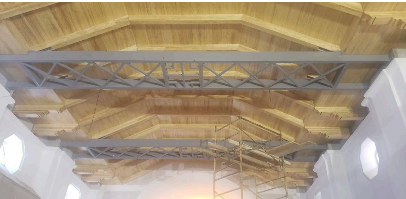
Figura 4.94 Cielo falso de madera y estructura de soporte
