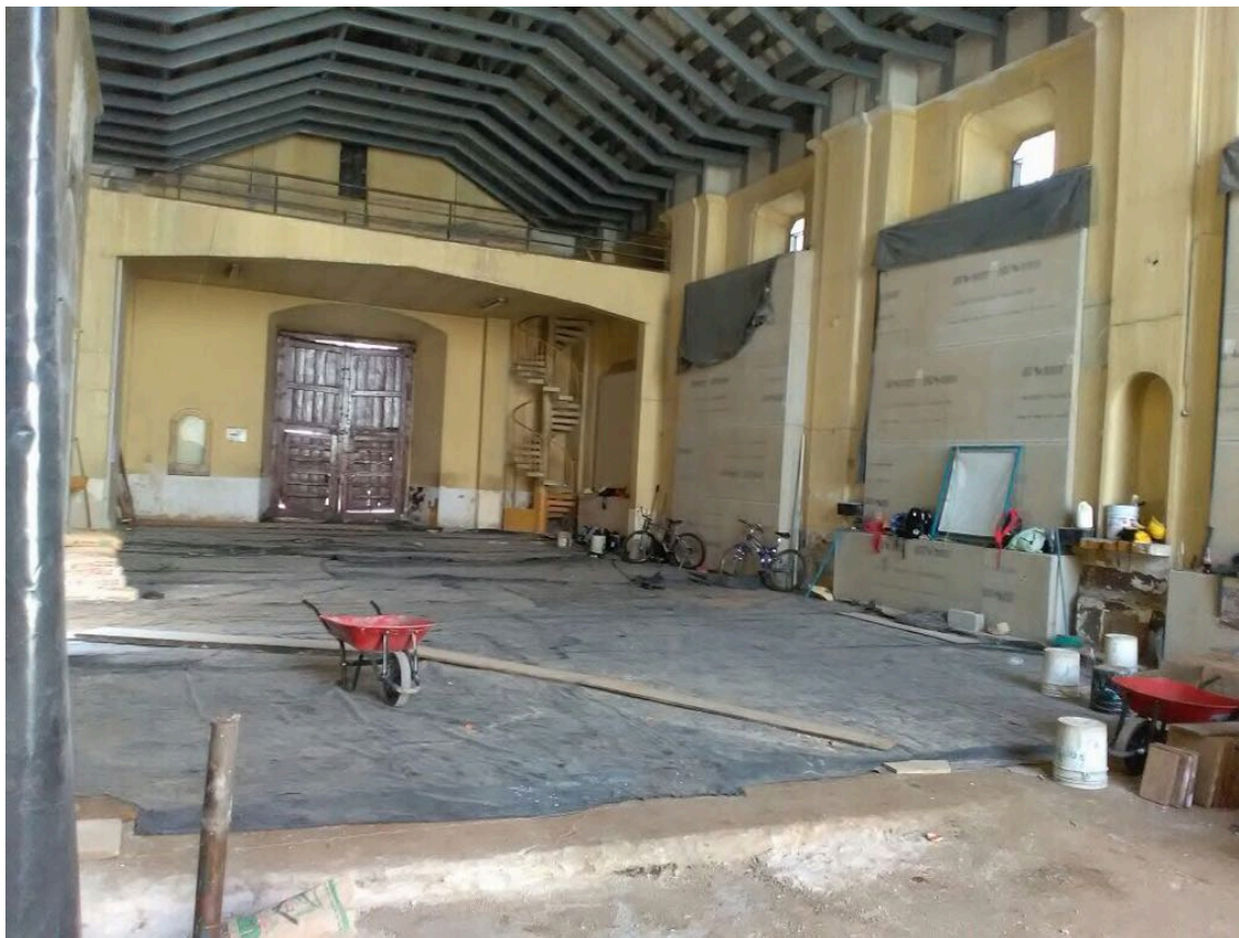
Figura 4.89 Reparación y refuerzo de muro lateral Norte
