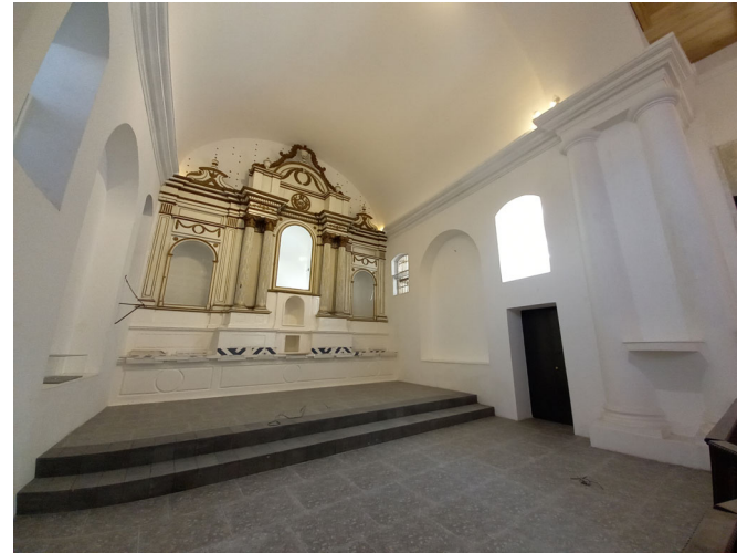
Fotografía 18 - Lateral derecho del presbiterio, nótese la forma del cielo falso sobre el área del altar mayor.
