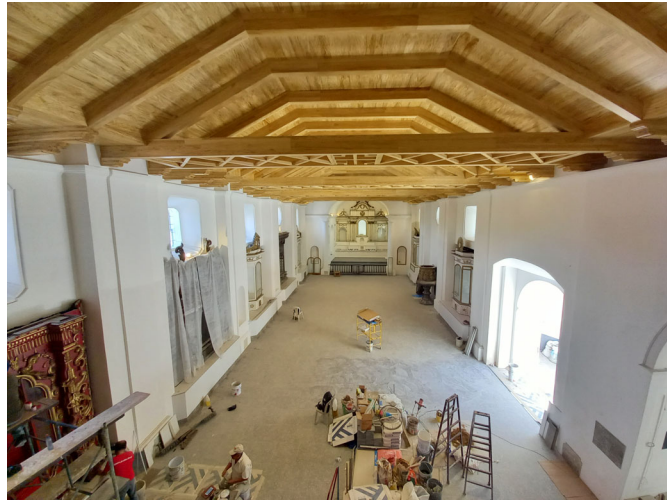
Fotografía 25 - Vista de la nave del templo desde el coro alto.
