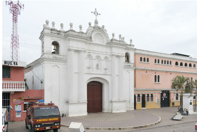
Fotografía 2 - Fachada principal (oeste u occidente) desde lado izquierdo.
