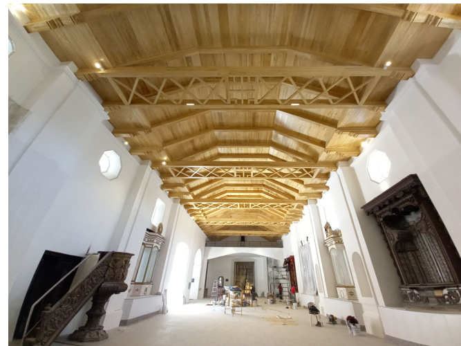
Fotografía 22 - Nave del templo desde el presbiterio, al fondo se observa la puerta principal y el coro alto.
