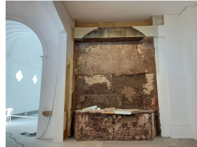
Fotografía 11 - Detalle de banco o altar lateral, nótese que tanto el altar como la mitad del muro están hechos de calicanto y rafas de ladrillo, mientras que el resto se conforma de adobe.
