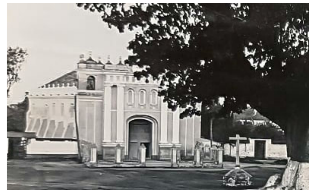
Figura 2 - Fotografía ca. 1938-1940 en donde se aprecia los contrafuertes y remates o perillas sobre el muro lateral norte del templo, así mismo se observa la cubierta de teja de barro, la verja perimetral del atrio y la cruz atrial. Fotografía de la colección de las hermanas Herrera Escobar, facilitada por José B. Fernández el 25 de febrero de 2020.
