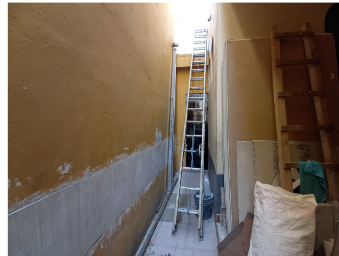
Fotografía 6 - Sacristía adosada al muro lateral sur del templo.
