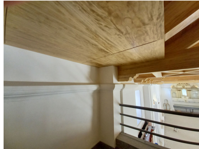
Fotografía 26 - Esquina norte del coro hacia la nave principal, nótese los canes de madera sobresaliendo del muro y aparentando sostener los tensores de metal forrados de madera.
