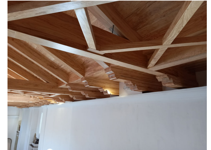
Fotografía 28 - Canes de madera sobre muro lateral sur del templo.
