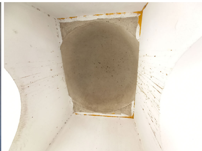
Fotografía 32 Izquierda: campanas ubicadas en la torre norte. Derecha: detalle de la cupula de concreto reforzado de la torre norte, esta torre fue reconstruida tras su pérdida total durante el terremoto de 1976.
