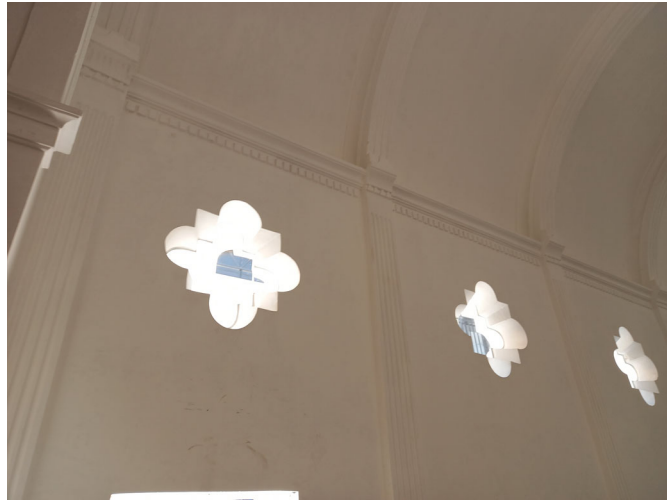
Fotografía 9 - Detalle de ventanas en la capilla de Jesús de Trujillo.
