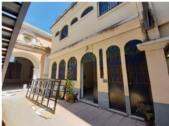
Fotografía 16a - Oficinas parroquiales adosadas al muro lateral sur del templo, nótese la puerta lateral.
