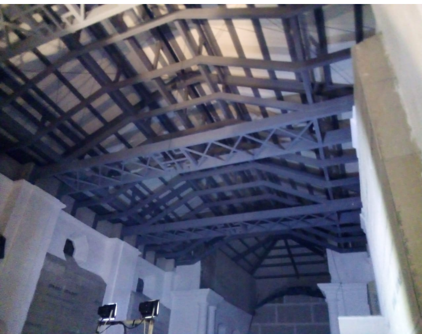
Figura 4.85 Estructura de techo completa
