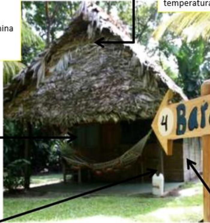
Muros de bahareque, caña recubierta de tierra cruda
