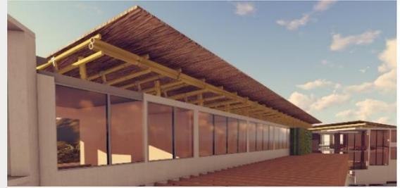
El remate de los techos inclinados de bambu del proyecto, crean el énfasis en cada módulo. Así mismo genera flujo de aire interno en el tercer nivel, siendo este el que más incidencia solar tendría.
