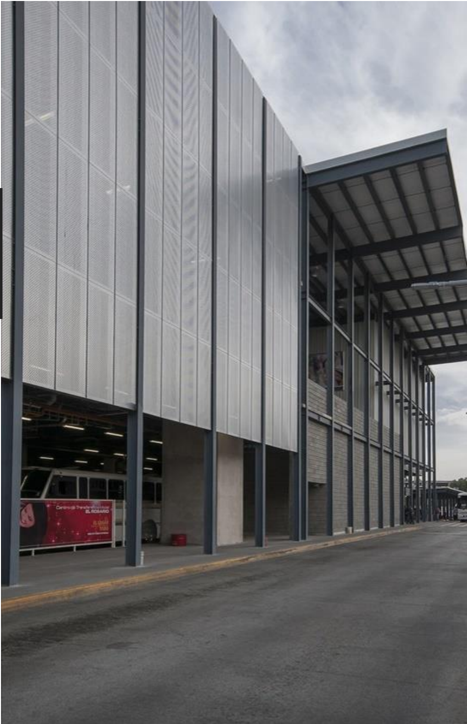
Fotografía 03: Centro de Transferencia Modal El Rosario/CC Arquitectos Enero 2014
