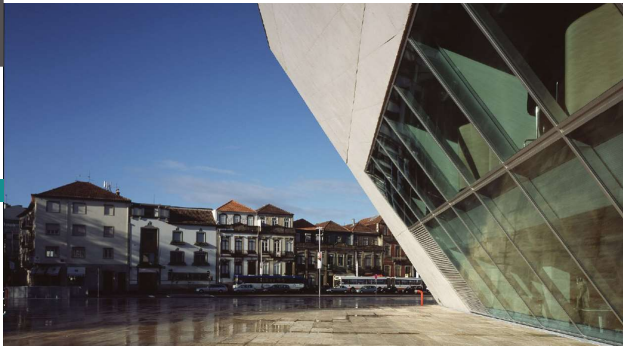
Vista exterior. Fuente: Plataforma Arquitectura
