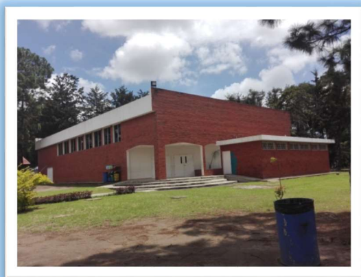
Fotografía 39, Ingreso Edificio Juvelim
