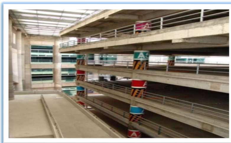
Fotografía 80, estructura de Torre de Parques
