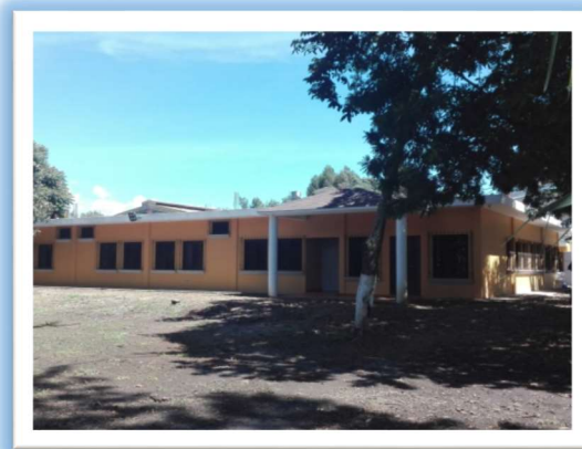
Fotografía 51, Edificio Casa Caleb 2
