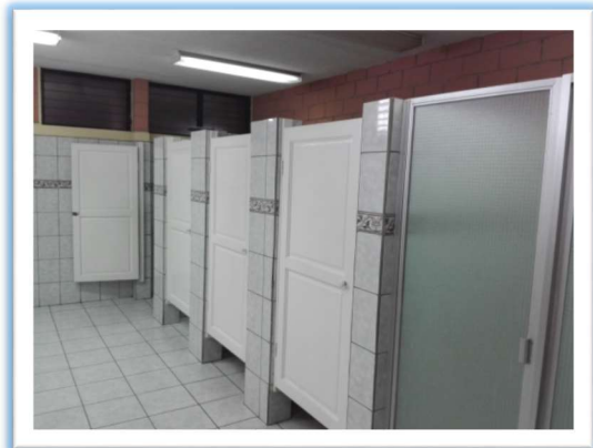
Fotografía 63, Servicio Sanitario Mujeres
