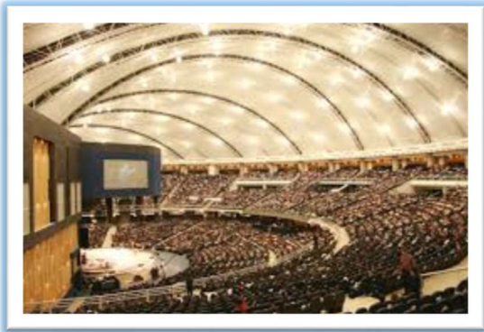
Fotografía 79, Vista Interior del Auditorio
