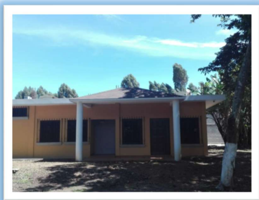
Fotografía 50, Edificio Casa Caleb
