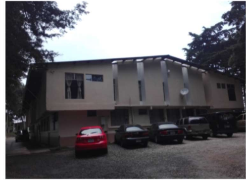
Fotografía 89, Fachada Frontal del Edificio Administrativo
