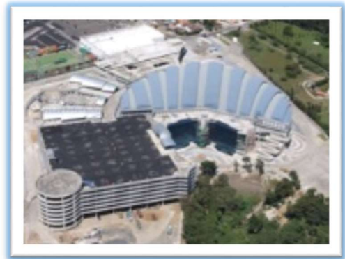
Fotografía 75, Torre de Parqueos Megafrater
