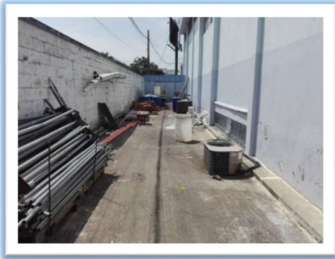
Fotografía 57, Área de Mantenimiento Actual
