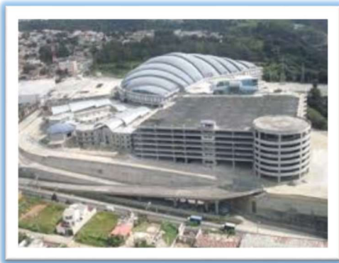
Fotografía 76, Torre de Parqueos Megafrater
