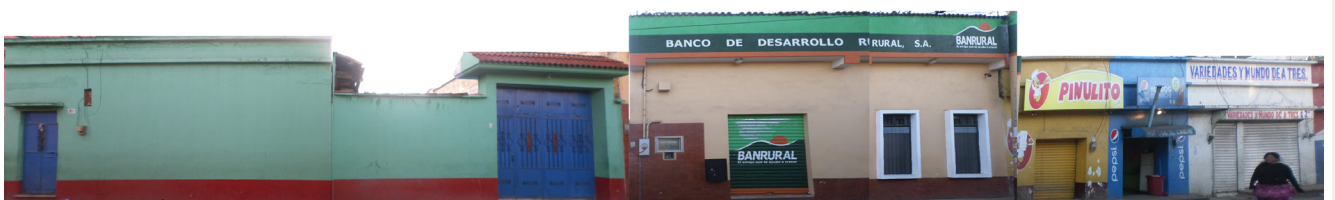
Fachada Casa Verde.
